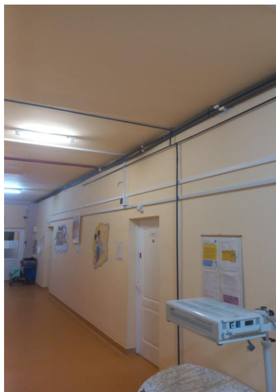
Inlocuire retea apa calda /apa rece sectie Obstretica Ginecologie
