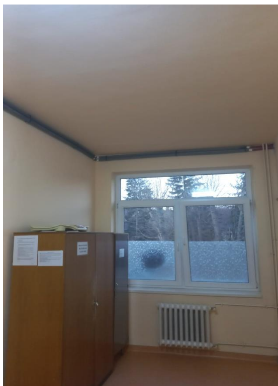
Inlocuire retea apa calda /apa rece sectie Obstretica Ginecologie
